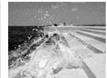
MEERESORDEL 2006 hat der Architekt Nikola Basić auf einer Länge von 70 Meter unter der Strandpromenade von Zadar 35 Orgelpfeifen horizontal eingelassen. Die Luftöffnungen sind in den Stufenabsätzen.
